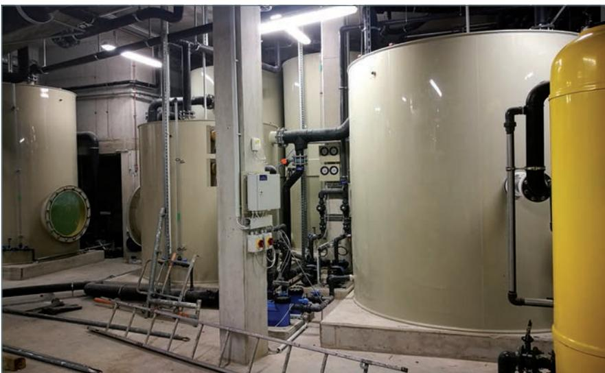
■ ... sowie Aktivkohlefilter und Rohwasserspeicher für das Planschbecken, Fotos: 4a Architekten GmbH, Stuttgart
