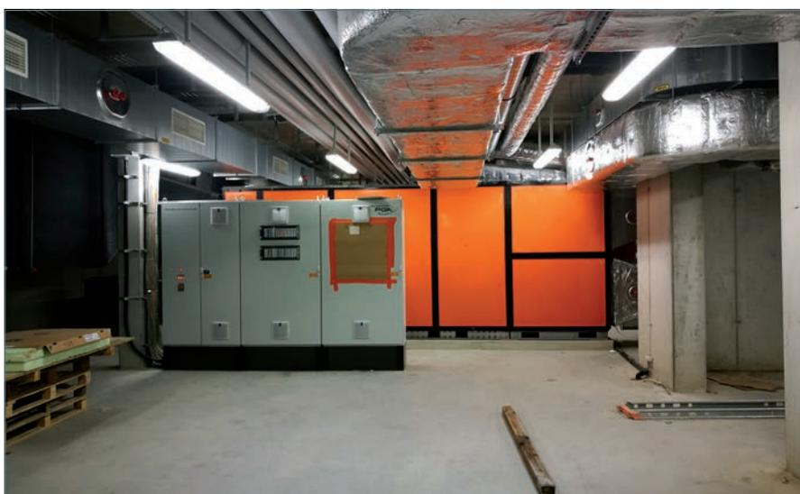
■ Der Schaltschrank mit der Mess- und Regeltechnik, Foto: 4a Architekten GmbH, Stuttgart
