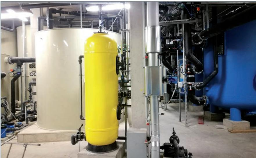
■ Die Technikzentrale „Badewasser“ mit Filtern und Spülabwasserspeicher ...
