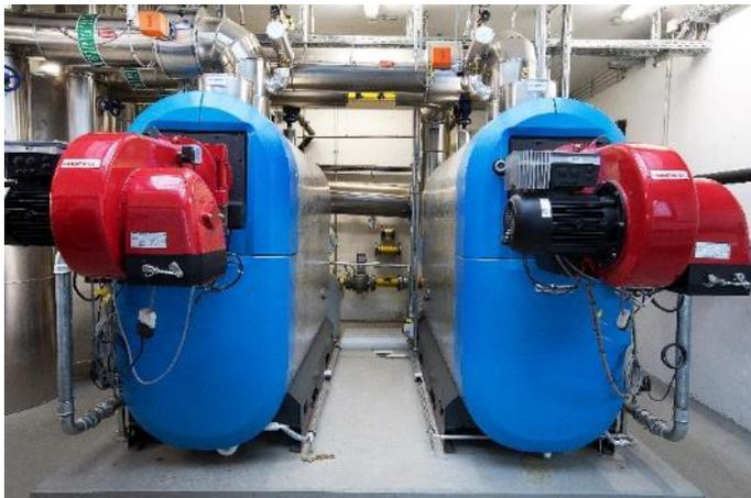
**Abbildung 10:** Um Spitzenlasten abzufangen, ergänzen zwei Gas-Brennwertkessel Logano plus SB745-800 das BHKW. Die Wärmeerzeuger sind auf den Einsatz in großen Objekten ausgelegt und zeichnen sich durch ihre besonders hohe Energieausbeute aus. **Bild: Buderus**
