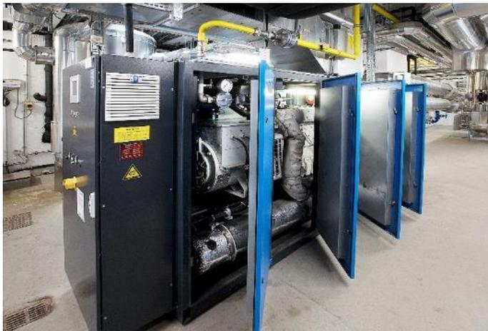
**Abbildung 05:** Im Inneren des BHKW arbeiten ein Gasmotor, ein Drehstromgenerator und ein Wärmetauschersystem zusammen. **Bild: Buderus**
