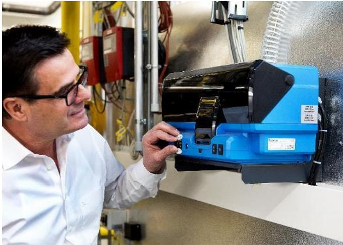
**Abbildung 12:** Die Parameter der beiden Gas-Brennwertkessel Logano plus SB745-800 lassen sich über das Regelgerät Logamatic 4321 kontrollieren, das direkt am Kessel angebracht ist. **Bild: Buderus**
