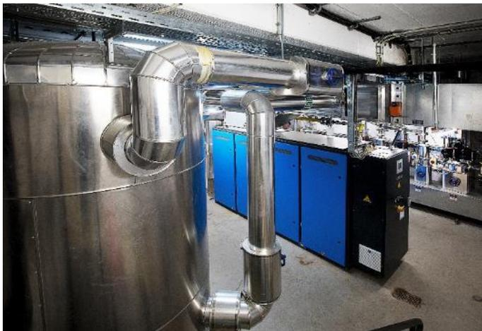
**Abbildung 08:** Um das BHKW optimal auszulasten, sind zwei Pufferspeicher mit je 3.000 Liter Fassungsvermögen ins Heizsystem eingebunden. **Bild: Buderus**
