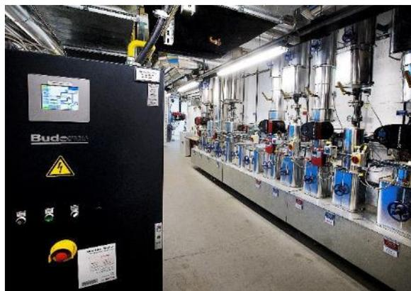
**Abbildung 13 und 14:** Über neue Nahwärmeleitungen versorgt das Buderus Heizsystem die vier Gebäude auf dem Schulgelände von der Heizzentrale aus mit Wärme. **Bilder: Buderus**
